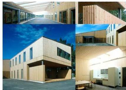
DER WERKSTOFF HOLZ IST ZUR ERZIELUNG NIEDRIGSTMÖGLICHER BAUUNTERHALTUNGSKOSTEN SORGFÄLTIG UND NACHVOLLZIEHBAR HINSICHTLICH DER BEANSPRUCHUNG DIFFERENZIIERT IN DURABLE, WEIßPIGMENTIERT GEÖLTE FICHTENHOLZWÄNDE UND DECKEN, STRAPAZIERFÄHIGE TÜREN, OBERGESCHOSSIGE BODENBELÄGE, HANDLÄUFE UND GARDEROBEN ETC AUS RÄUCHEREICHE UND
