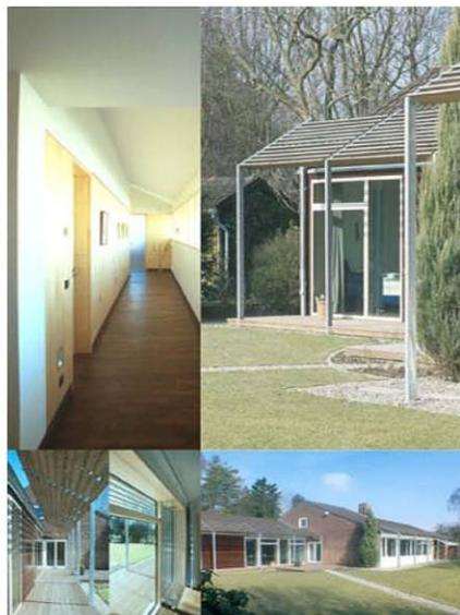
DIE BAUKÖRPERHÜLLE IST GEFÜGT AUS GESCHOSSFASSENDEN NORMSTAHL-U-PROFIL-BÄNDERUNG MIT ZWISCHENGEFÜGTEN, RAUMHOHEN HOLZ-METALL-FENSTERÜBEN, GESCHLOSSENEN ZWISCHENSTÜCKEN MIT GEPUTZTER DÄMMUNG UND AKZENTUIERT GESCHICHTETEN FELDERN AUS HOLZ- GLAS FÜR DIE BEREICHE DES ERDGESCHOSSES UND DER SUBSTRATIV BEHANDELTEN BALKONZONEN.
